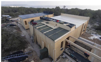
■ Aislamientos termoacústicos en vivienda sostenible en Formentera.
