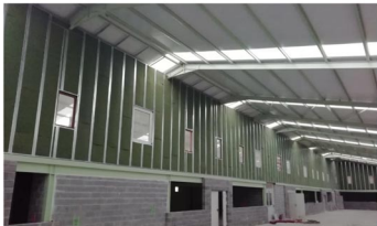
■ Aislamiento termoacústico de nave industrial en Pamplona . GEOPANNEL® CLASSIC 60 mm.
