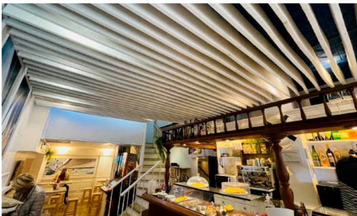
■ Acondicionamiento acústico en restaurante en San Sebastián. GEOPANNEL® NOISEFREE Wh 30 mm (Serie bafles).
