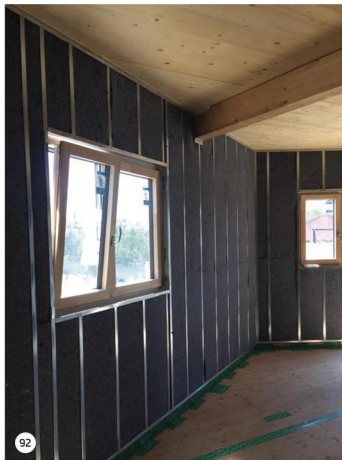
■ Aislamientos termo acústicos en Las Carolinas (Residencial Entrepatios) en Madrid. GEOPANNEL® PYL 2.0 40 mm y 60 mm, y GEOPANNEL® INPAT.
