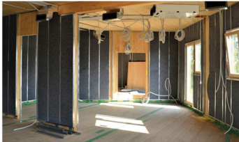
■ Aislamientos acústicos y térmicos para edificio de alta eficiencia energética en Madrid . GEOPANNEL® PASSIV 80 mm y GEOPANNEL® INPAT.
