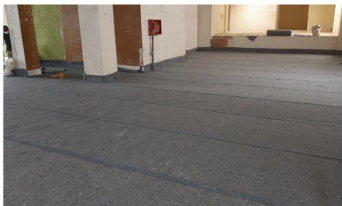
■ Aislamiento acústico de gimnasio en Barcelona . GEOPANNEL® PYL 2.0 40 mm y 60 mm, y GEOPANNEL® INPAT.
