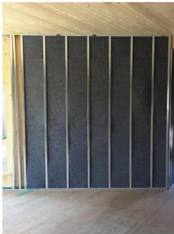
■ Aislamientos termo acústicos en Las Carolinas (Residencial Entrepatios) en Madrid. GEOPANNEL® PYL 2.0 40 mm y 60 mm, y GEOPANNEL® INPAT.
