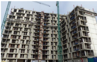
■ Aislamientos termoacústicos en bloque de 90 viviendas. Zaragoza.
