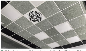
■ Aislamiento y acondicionamiento acústico de edificio de oficinas en Logroño . GEOPANNEL® GEOPET COLOR 60 mm verde y NOISEFREE Wh 60 mm color negro.
