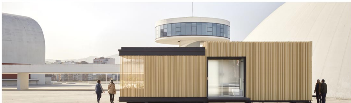
■ Aislamiento termo acústico de ROOM 2030, La Habitación del Futuro.
