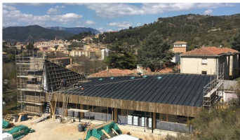
■ Aislamientos para nuevo Guarderío Forestal en Estella , edificio PASSIVHAUS de bajo impacto ambiental
