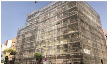
■ Aislamientos de fachada ventilada en bloque de 53 viviendas en Badalona . GEOPANNEL® PLUS FR2 60 mm.
