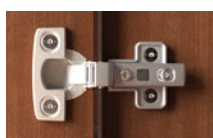
Fijación de metal sin ningún daño del material
